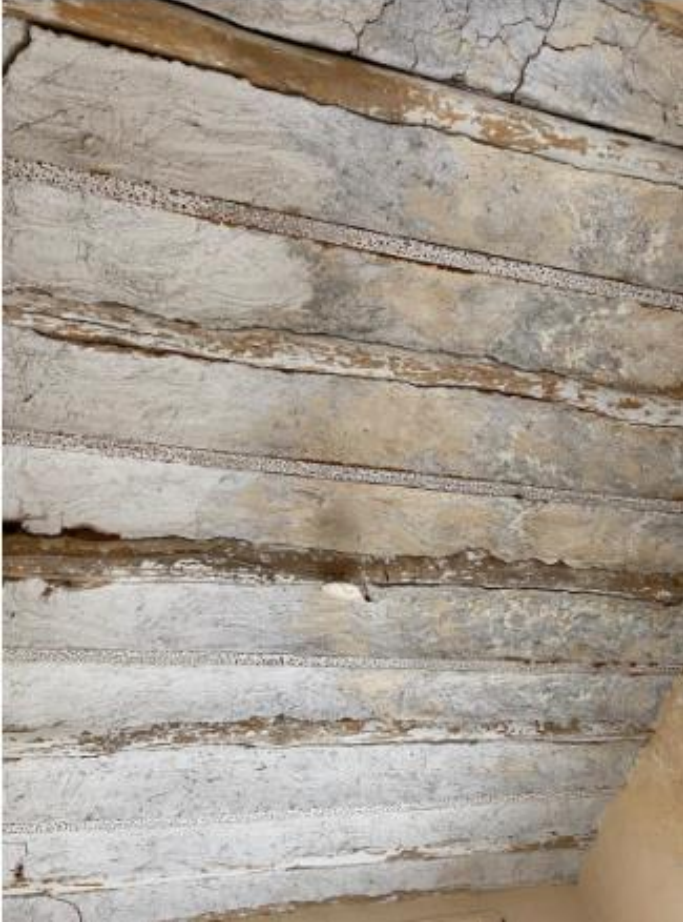
Şekil 4. Cas ev döşemesi ahşap hatıl ve demir profil destekler
