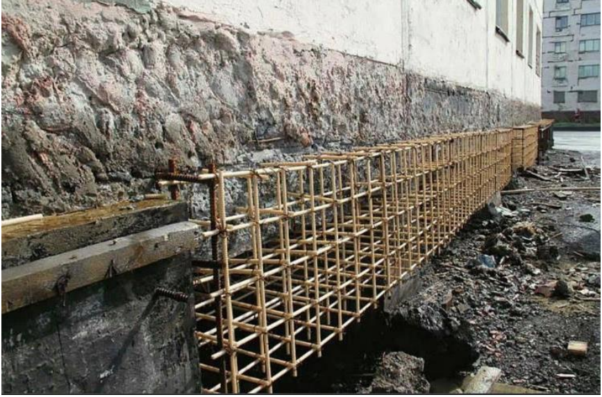
Şekil 3. Korozif Ortamlarda GFRP kullanımı (Fiberglass (GFRP) Composite Rebar,2019)
