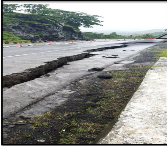
Şekil 2. Genişleyen taban zemini üzerine oturan esnek yol üstyapısının bozulması (Tiwari & Satyam, 2020)
