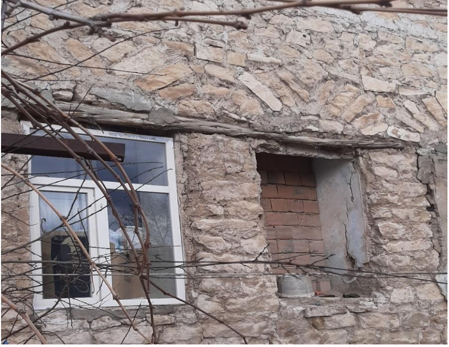
Şekil 10. Örnek bir cas evinde pencere üstü boydan boya ahşap lento
