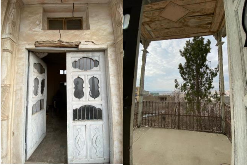
Şekil 6. Cas ev balkon ve ahşap doğraması
